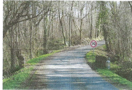
Pont sur le Gendarme, aux Coureau, sur l'ancienne route de la Poste
