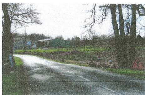
Pont sur le ruisseau Le Palais, sur la route St. Médard à Puisseguin, au nord du bourg de Petit Palais
