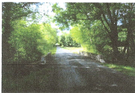
PONT SUR LE PALAIS ET ROUTE DE CHOUTEAU(PUISSEGUIN) LAMOTHE Ce pont, placé dans un méandre du cours d'eau, paraît protégé par des maçonneries arrondies de part et d'autre du parapet.
